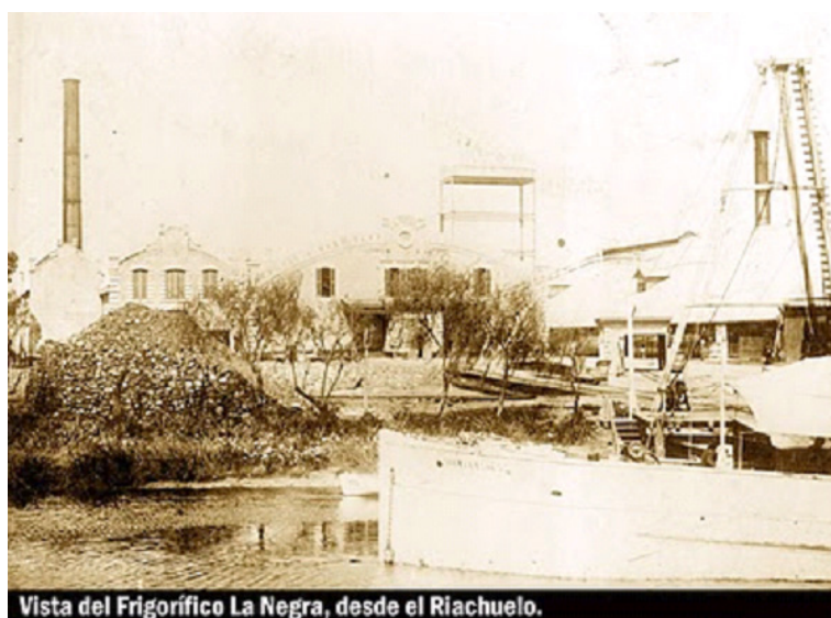
Figura 11. Vista del Frigorífico La Negra desde el Riachuelo, primer frigorífico de Barracas.
