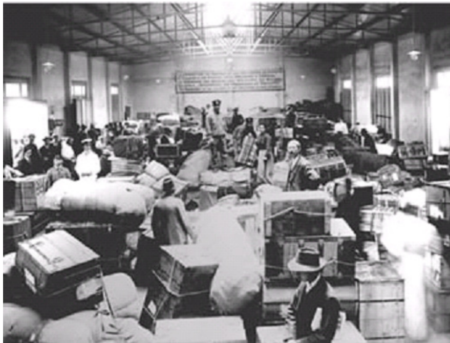
Figura 5. Depósito del Hotel de Inmigrantes
